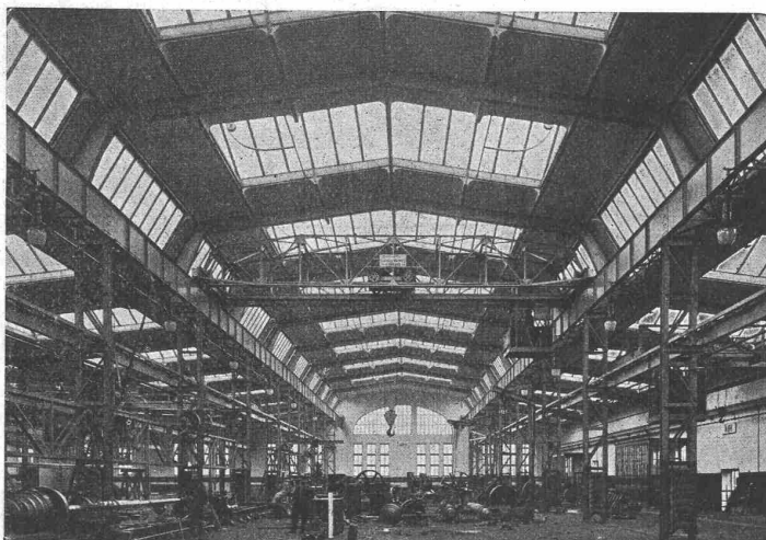
Werkstätten Eisenwerk Wülfel bei Hannover.
