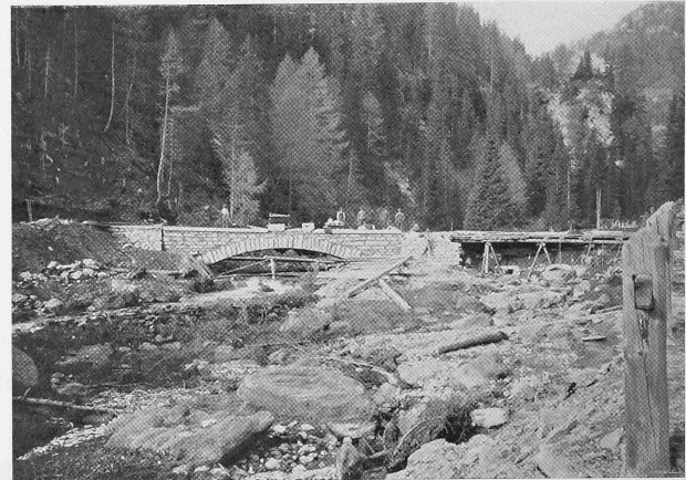
Abb. 14. Schergenbachbrücke bei Km. 14,7.
