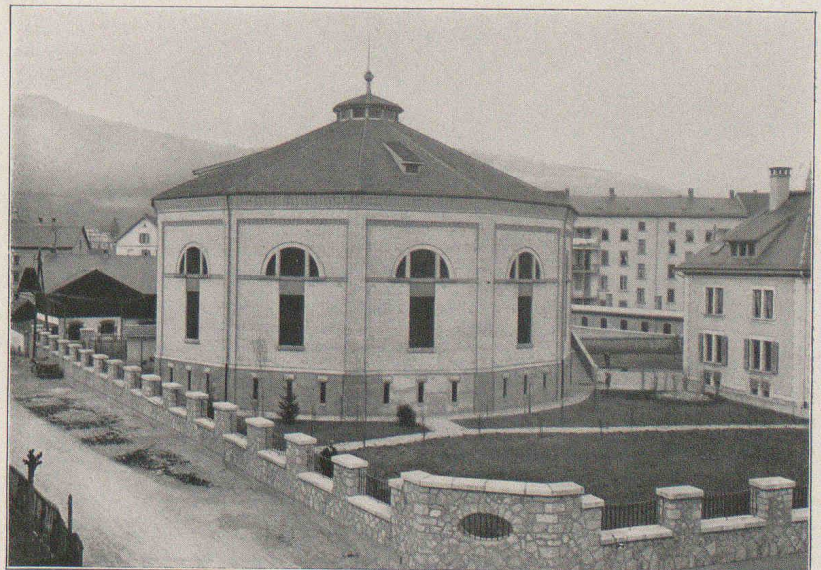
Schutzhaus für den Behälter in Delsberg.
