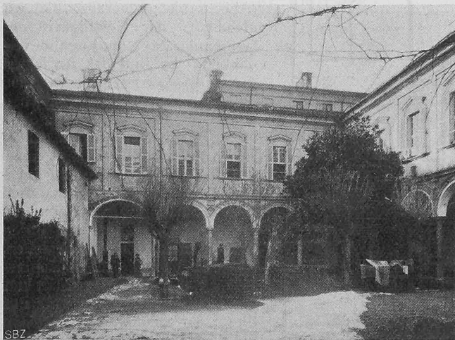
Abb. 2. Hofansicht des „Ospedale vecchio“.
