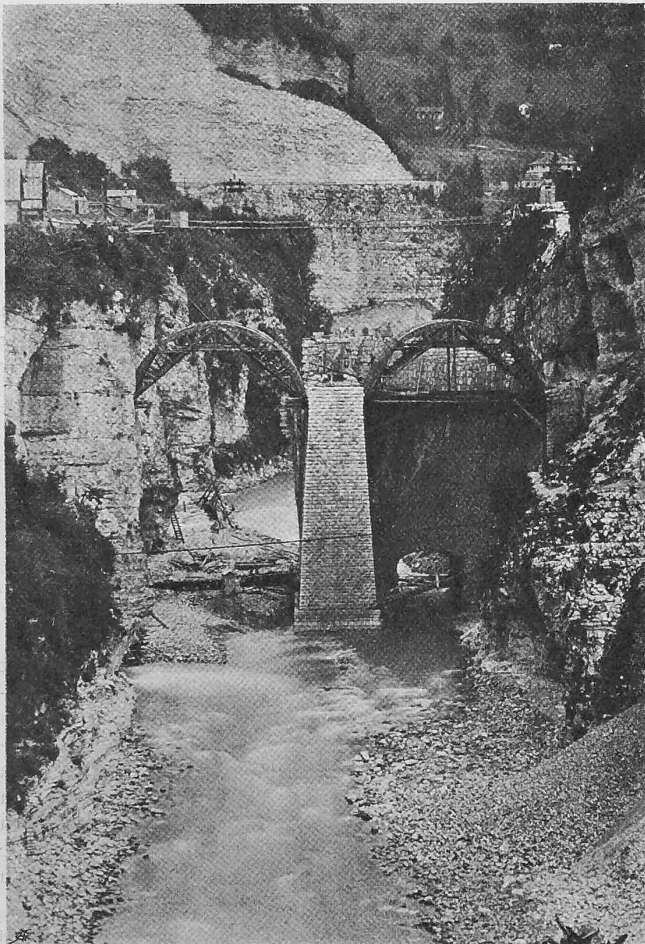
Abb. 11. Blick auf die Baustelle vom Ponte della Serra.
