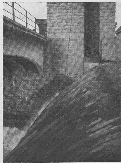
Abb. 38. Ganz umgelegte Klappe Nr. 10. Ueberlaufmenge 100 m 3 /sek (25. III. 13).
