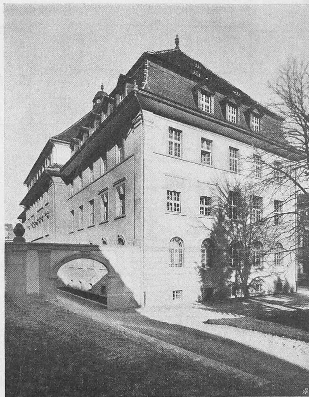
Abb. 4. Ansicht des Verwaltungsgebäudes von Süden.
