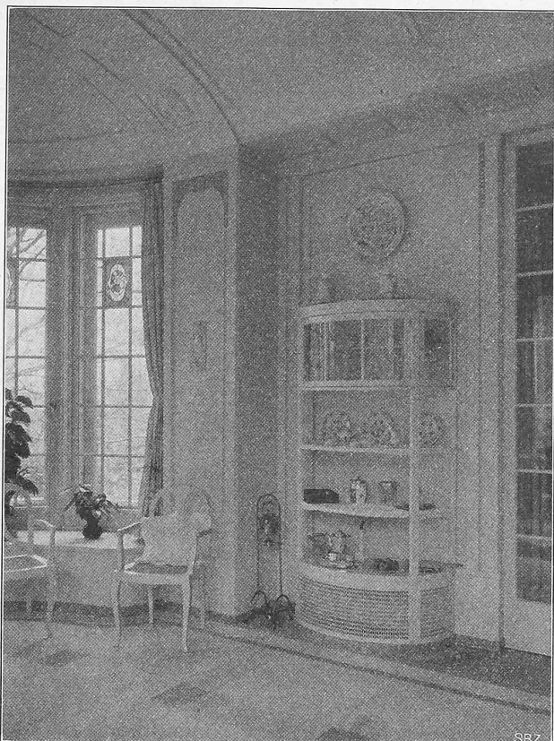
Abb. 2. Detail des Fenstererkers.
