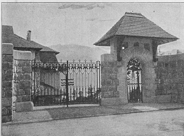
Fig. 41. Portail du jardin de la maison Kohler.
