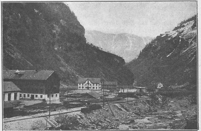
Abb. 55. Südseite. — Unterer Teil des Installationsplatzes.
