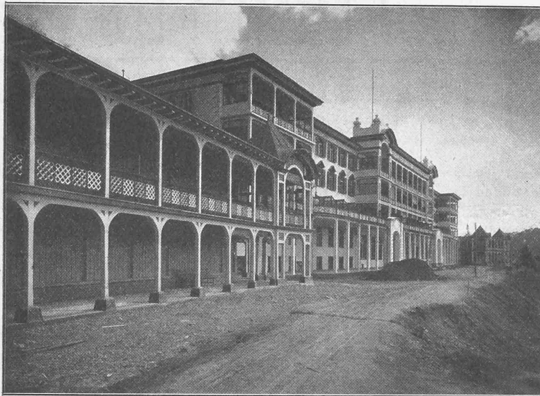
Photogr. Gebr. Wehrli, Kilchberg.
