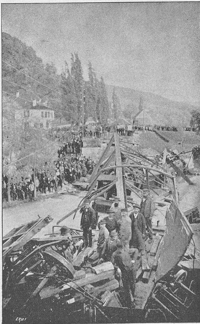
Ansicht der Zerstörung vom linken Widerlager aus. Aufnahme vom 16. Juni.
