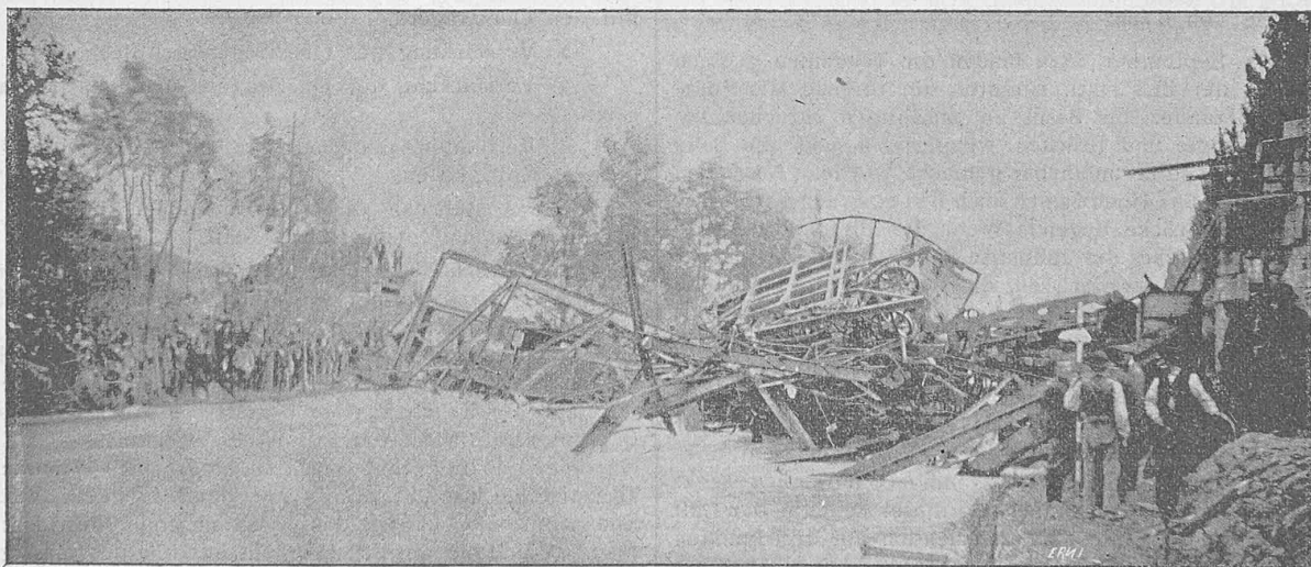
Ansicht der Zerstörung vom linken Ufer unterhalb der Brücke aus. Aufnahme vom 16. Juni.
