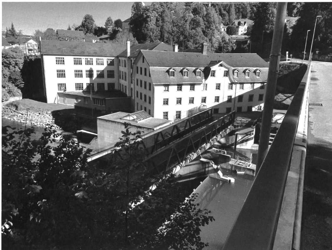
Die ehemalige Fein-Elast-Fabrik an der Thur von oben ...
