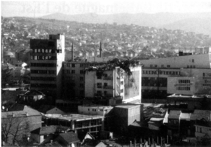
Un centre de télécommunications à Pristina (Kosovo) touché par un missile de croisière de l'OTAN.
