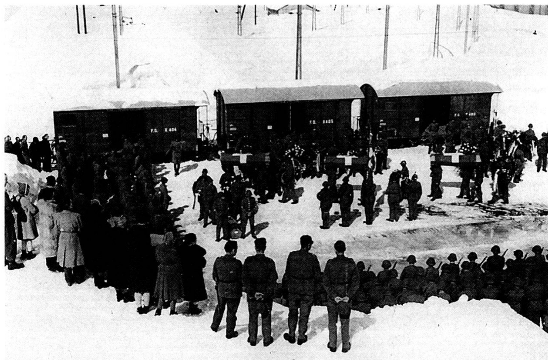
Le bare vengono portate nei vagoni per il trasporto al domicilio delle vittime (foto 2).
