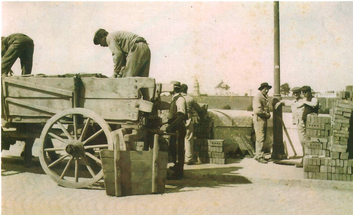
Ablad von Backsteinen auf der Rheinbrücke.
