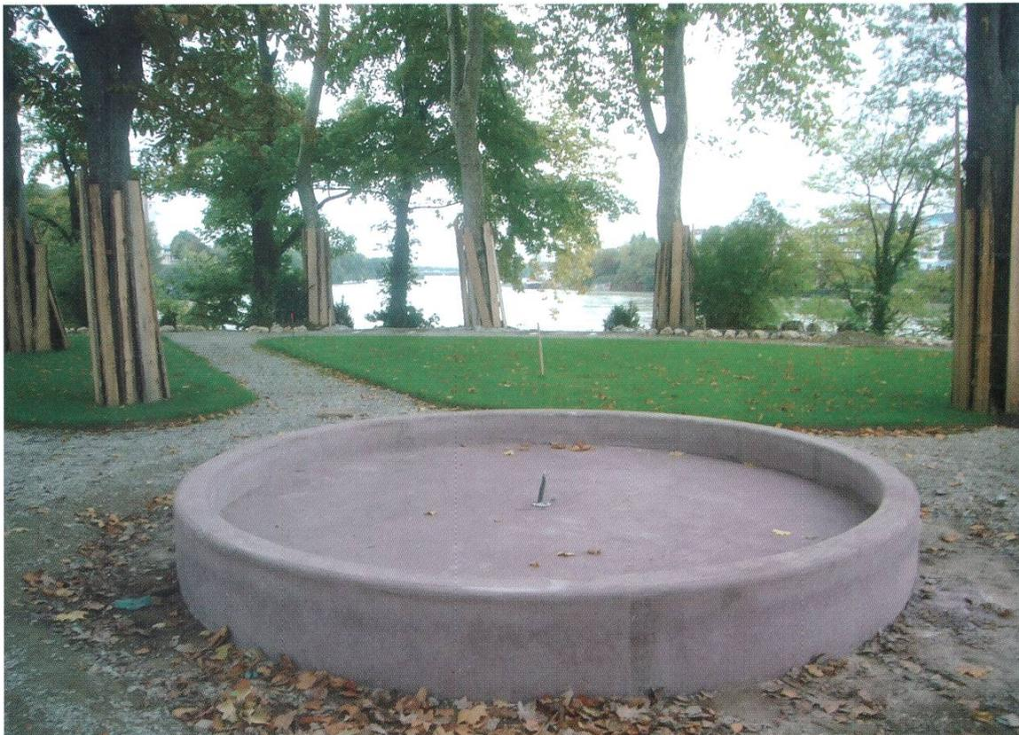
Neue in Beton gegossene Brunnenschale.
