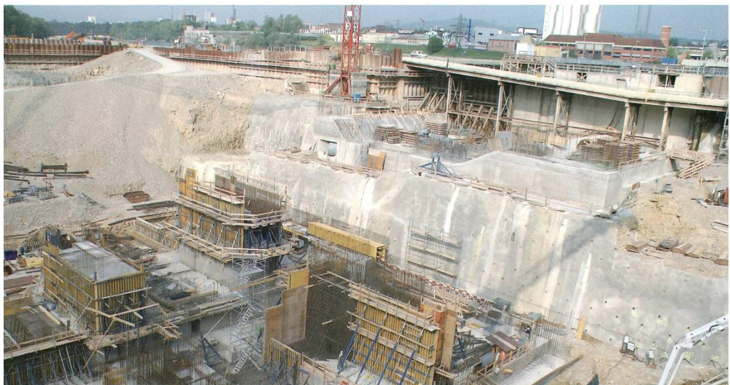
Insgesamt braucht es 120 000 Kubikmeter Beton und 12 000 Tonnen Armierungseisen, um das Maschinenhaus zu erstellen.
