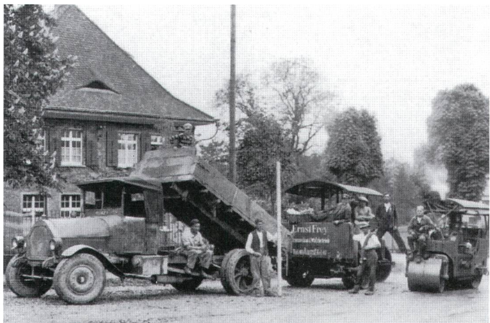
Baustelle in Rheinfelden 1930
