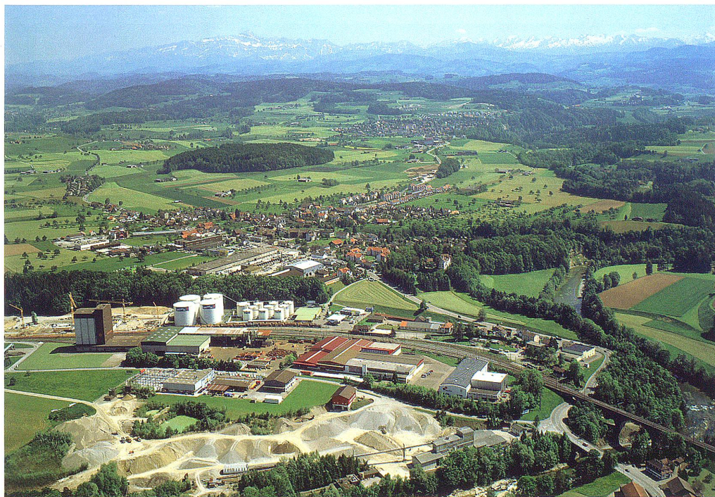
Das Industrieareal Salen/Niederstetten, auf welchem Aldi Suisse AG den Hauptsitz und das Ostschweizer Verteilzentrum baut, umfasst über 14 Hektaren.
