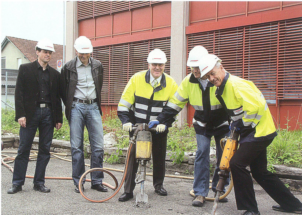
Dem ehemaligen Parkplatz geht es an den Kragen (v.l.): Adrian Scherrer und Hanspeter Hug (Architekten), Stadtrat Andreas Widmer, TBW-Geschäftsführer Markus Baer und Markus Hilber, Abteilungsleiter Gas und Wasser.
