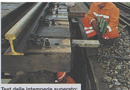
Test delle intemperie superato: sollevamento di un ponte in Vallese
