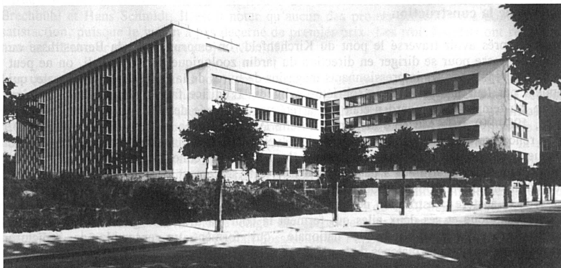
Vue du nord-ouest : au premier plan la Bernastrasse, à gauche les magasins sur huit étages, la terrasse de la salle de lecture ouvrant sur le jardin
