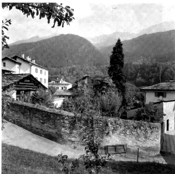
A sinistra: Muro sul lato posteriore con fienile. 2001
