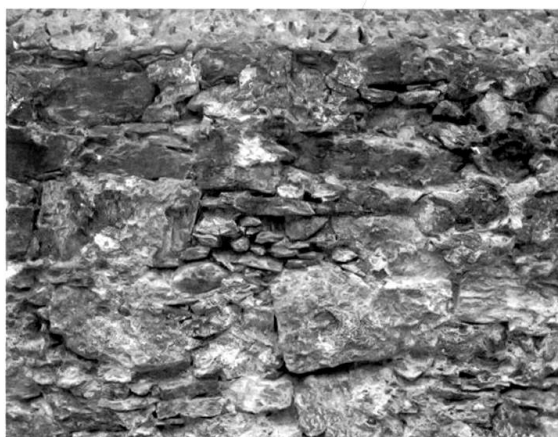
Muro posteriore (particolare)
