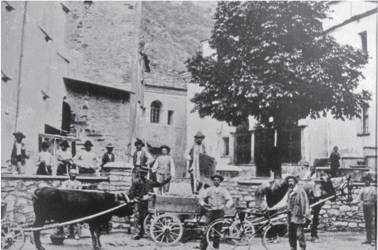
Lavori sul sagrato della Collegiata di San Vittore
