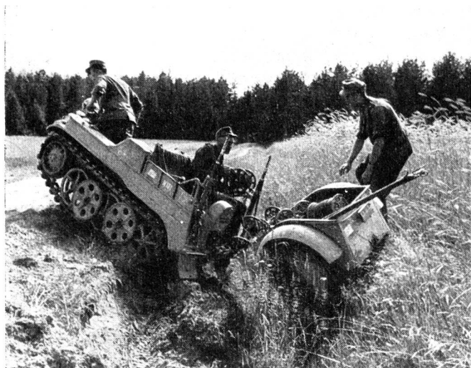
Leitungsbau mit dem Kettenrad in Deutschland.
