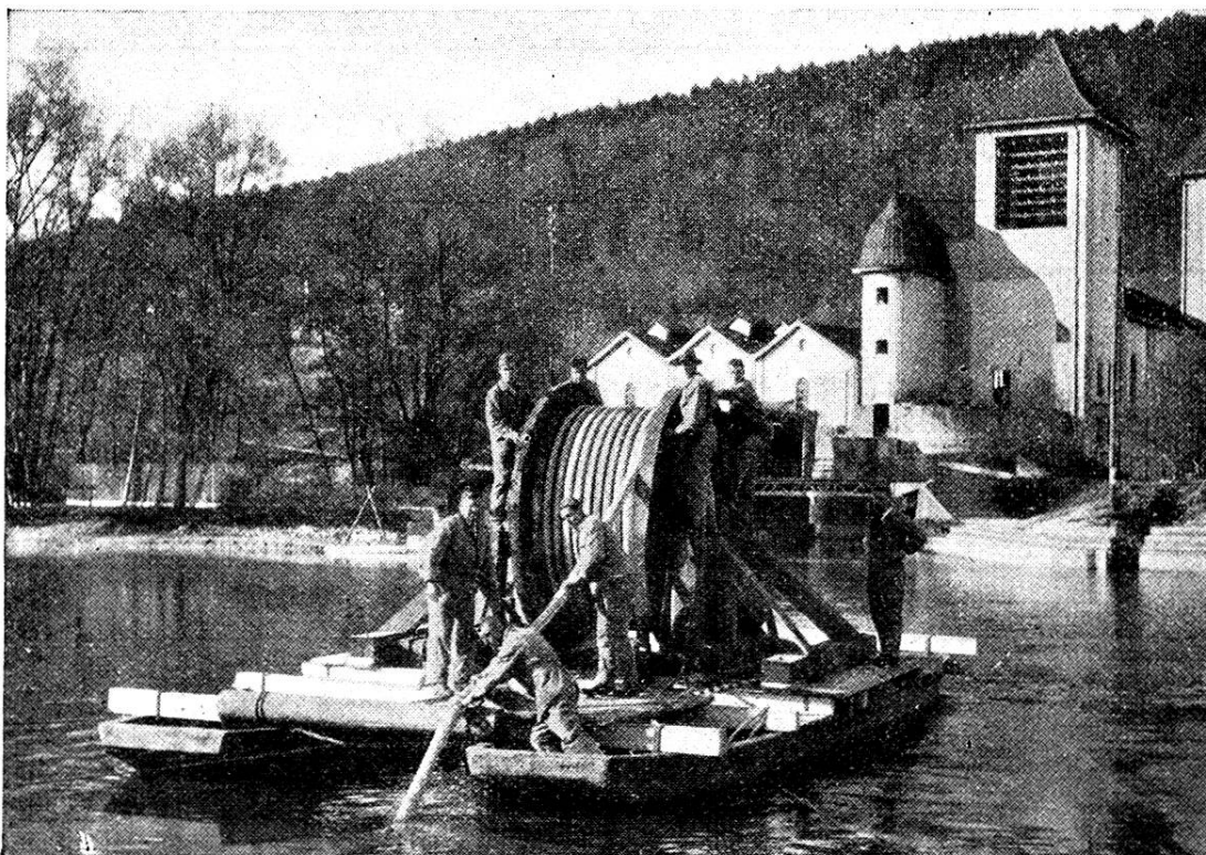
Verlegung eines Hochspannungskabels durch die Aare für das Elektrizitätswerk der Stadt Aarau.
