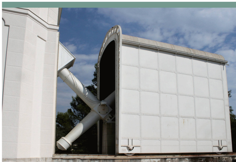
Abbildung 9: Die sich hier gerade öffnende Schutzkuppel bewahrt die frei stehenden Teleskopteile des Coudé-Refraktors vor den Unbilden der Witterung.
