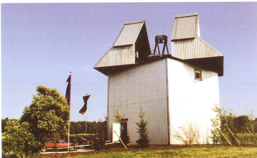
Fig. 1: Datei STW-B.JPG: Die aufgefahrene n Hälften des drehbaren Daches geben einen Spalt von 4 Meter Breite für die Beobachter und das Teleskop frei.
