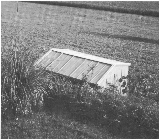
Abb. 1: Ein Gerätehaus aus Stahlblech dient R. Wirz in Hildisrieden als Kleinsternwarte. Die Tragkonstruktion für ein abfahrbares Dach würde den Garten zu stark beeinträchtigen.
