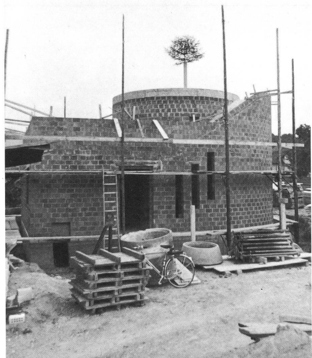
Fig. 4: Stand der Bauarbeiten im September 1974.
