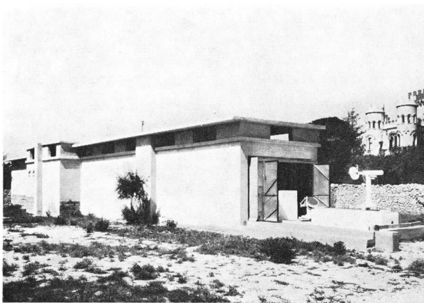
Abb. 10: Aufnahme des Horizontal-Teleskops von SW; der Coelostat vorn rechts geöffnet. Im Hintergrund rechts das Schlösschen (v. KLÜBER).
