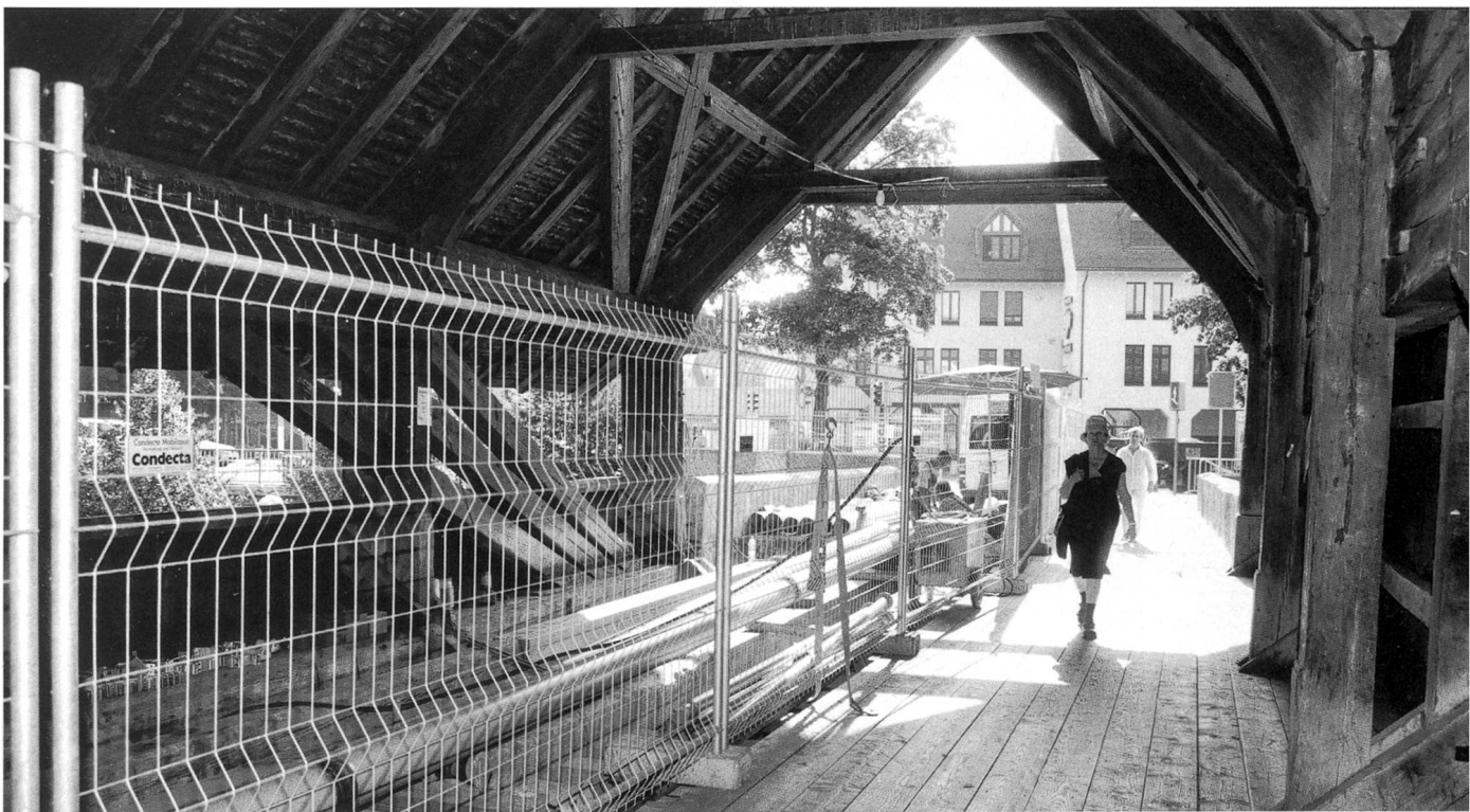
Sanierung der alten Brücke
