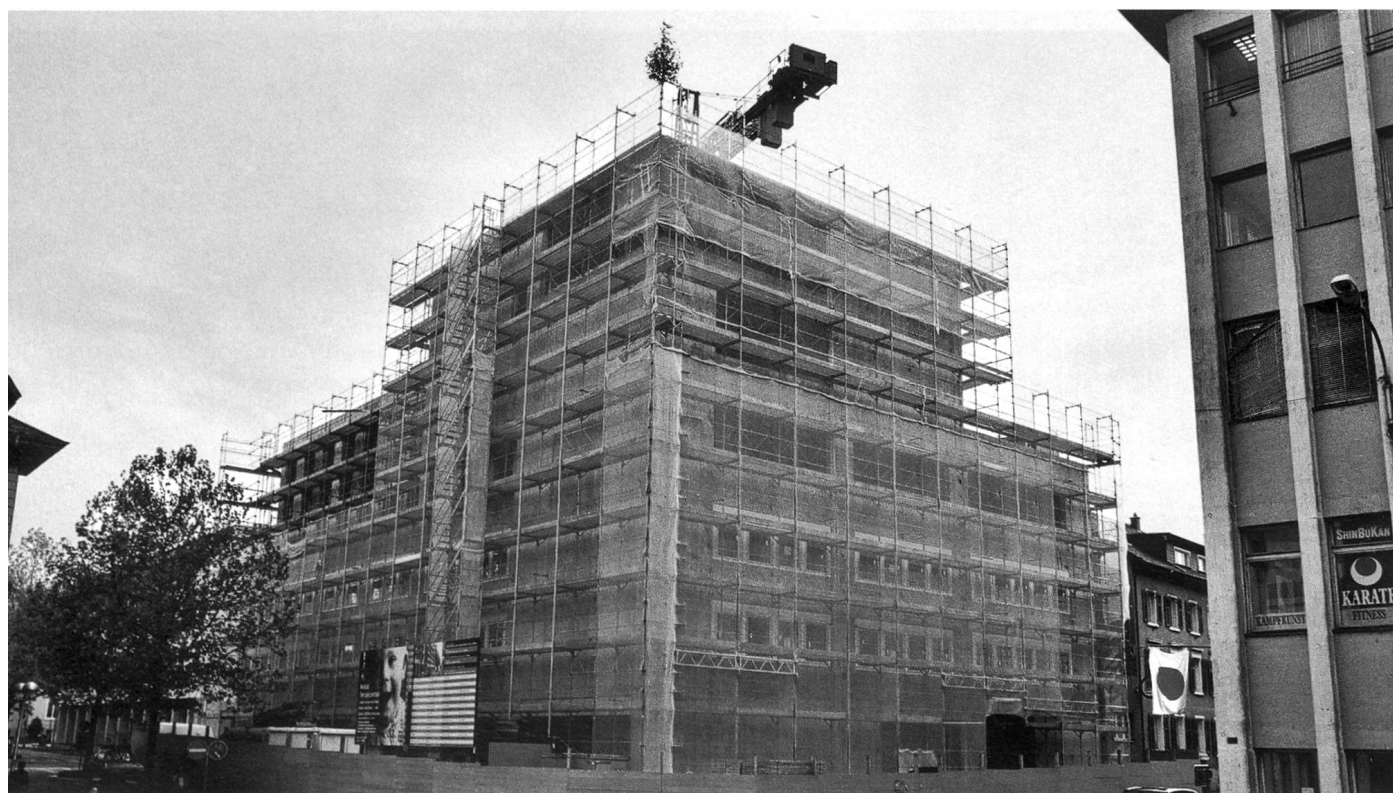
Neubau «Arkadis-Zentrum»: Aufrichte
