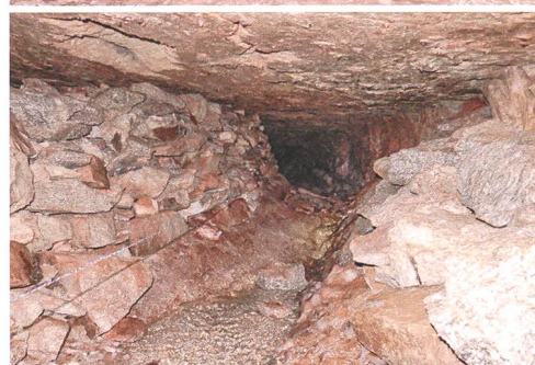
Abb. 18: Trockenmauern aus Granit im hinteren Teil der Kluft von 1719.
