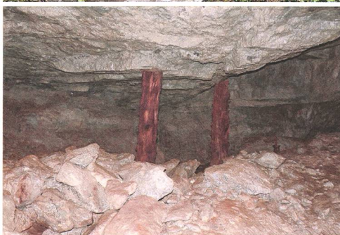
Abb. 22: Zwei Stützbalken der Kristalhöhle. Vom rechten Balken stammt Probe 43267.
