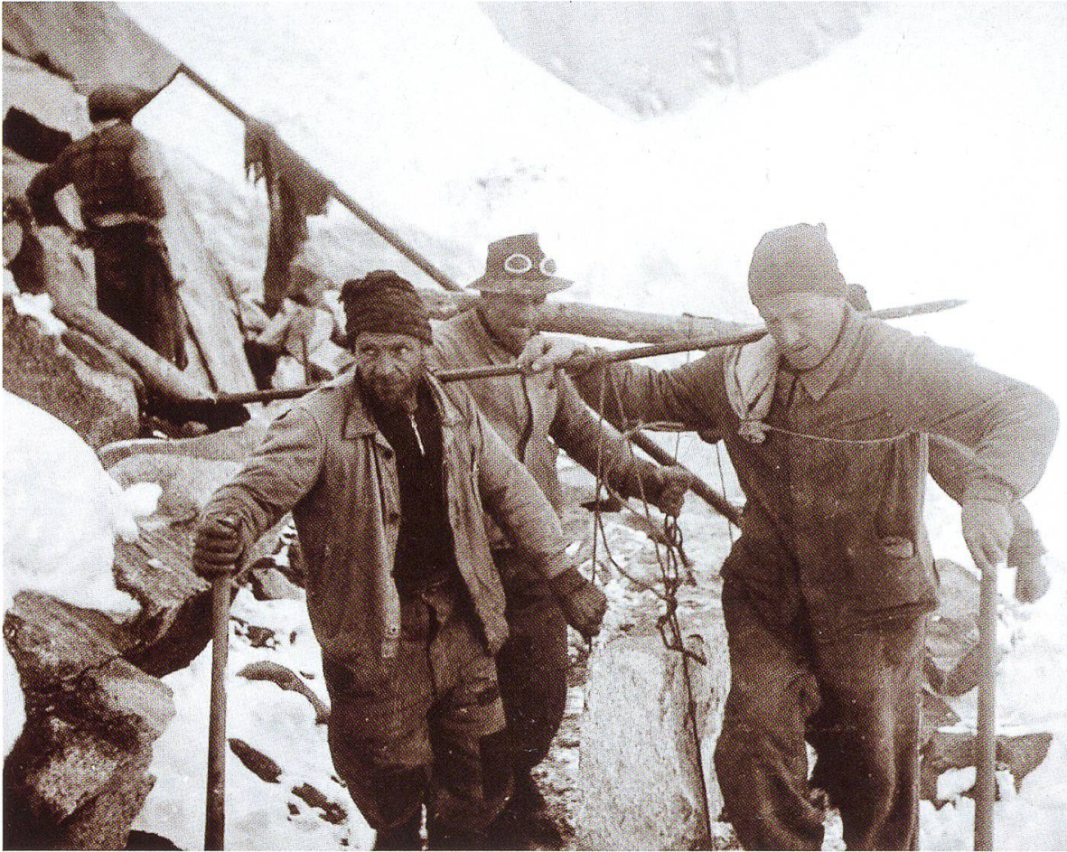
Abbildung 18: Steinträger beim Bau des Hangkanals am 28. Oktober 1944.
