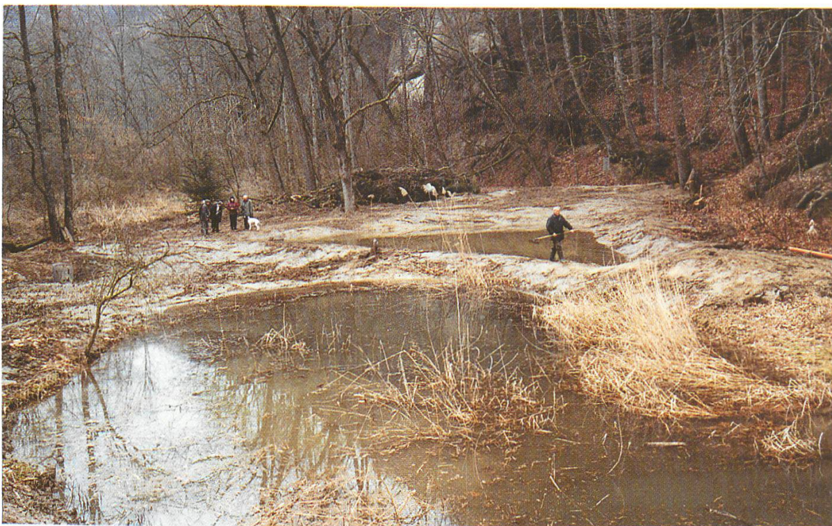
Abbildungen 14 und 15: Ausbau- und Gestaltungsarbeiten im Hirsried. (Fotos: W. Blaser, März 2004)
