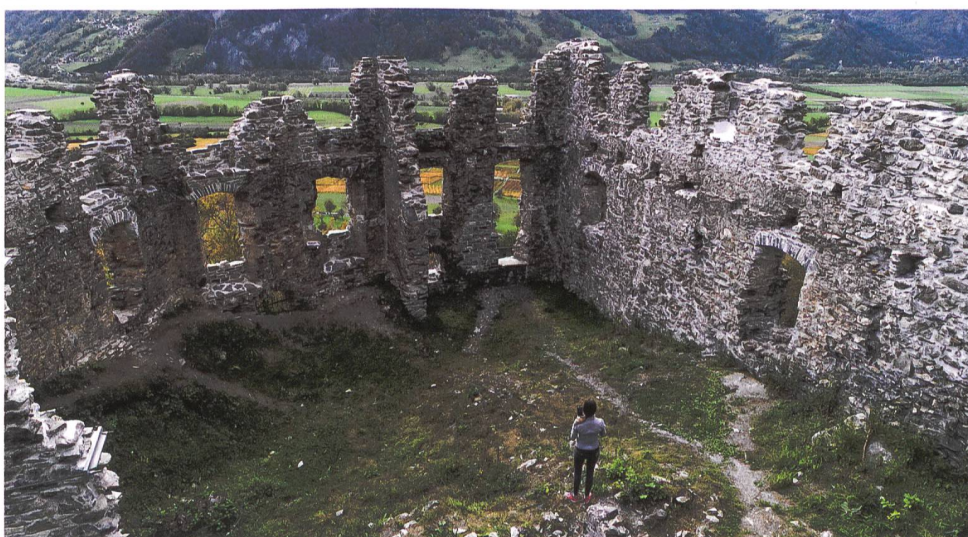
19: Wynegg GR. Übersichtsaufnahme Palas nach Sanierung, Sek M5, M6, M8, M9, nach Süden. Phase 7, Ausbau der Anlage durch Johannes Guler (Aufnahme 23.10.2019).
