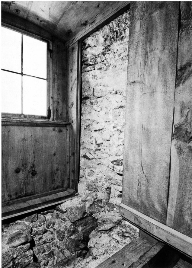
8: Müstair GR, Plantaturm. Ehemalige Abortnische, heute Fensternische im 2. Obergeschoss. Unter dem Fenster ist der Ansatz des Abortschachtes erkennbar und an der Ostwand der Abdruck der Sitzkonstruktion.
