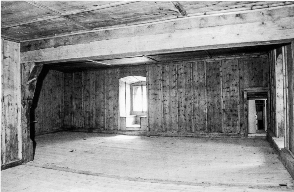
11: Müstair GR, Plantaturm. Das Dormitorium im zweiten Obergeschoss.
