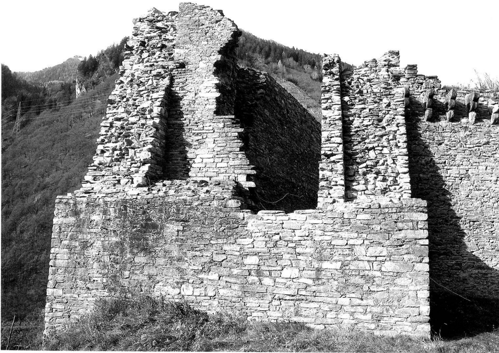
8: Der um 1400 gebaute Südturm wird nach 1480 durch 2 Meter starke Vormauerungen verstärkt, Sicht gegen Norden.
