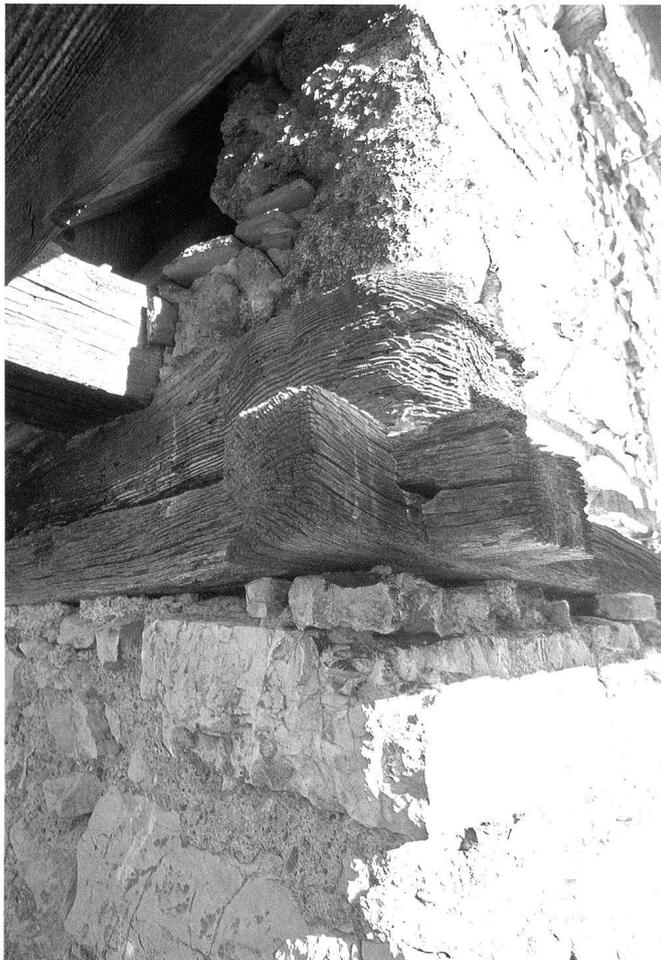
7: Überkämmt Kronbalken an der Südecke des Palas, vermutlich Auflager des Obergadens von 1375/1380, darüber Mauerschwelle des Dachstuhls von 1620–1622.
