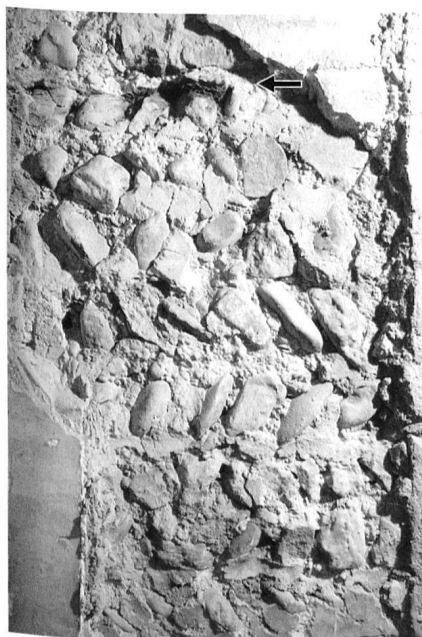
24: Kernbau I, Mauerkrone 4.4 von O.
