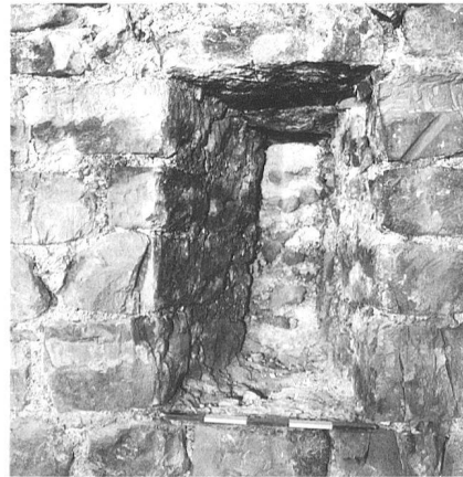
28: Kernbau II, EG, Fenster 9.2.
