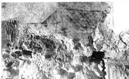
14: Kellerabgang. Die Malerei (26) entstand, als der Kellerabgang noch 2,2 m tiefer lag (16.1). Die Nordfassade (16) und die Kellerabgangsmauer (17/25) treffen exakt auf die Ecke der Mauer (11), welche sich nach Westen ins Nachbarhaus fortsetzt.
