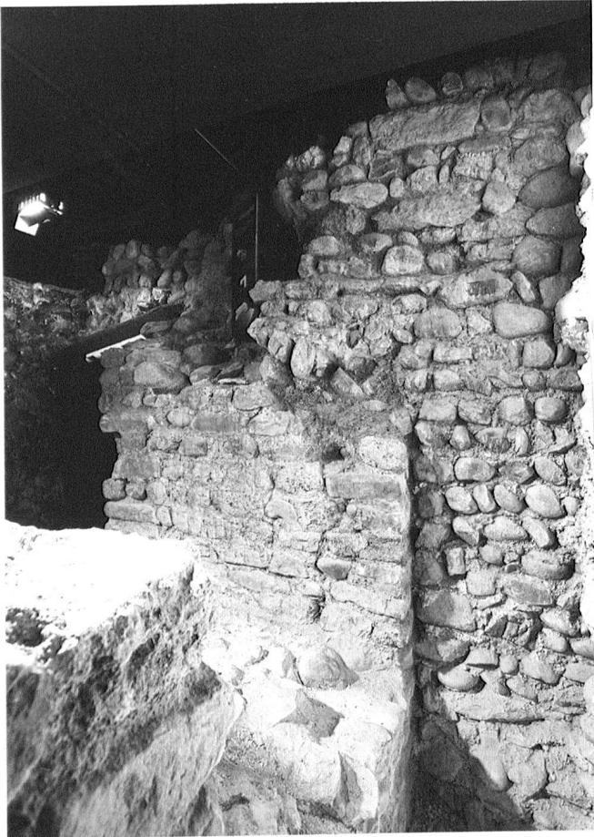
18: Zürich-Lindenhof 4, 1966/67. Blick von Westen an die Situation am Südrand des spätrömischen Kastells. Die teil- ausgebrochene östliche Wange des Turmzugangs (links) wird von der westlichen Fassadenmauer des jüngeren Pfalzgebäudes überlagert. Zustand 2011.
