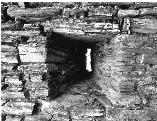
15: Turm, Mauer M1. Fenster 1.3, Innenansicht, von WSW.
