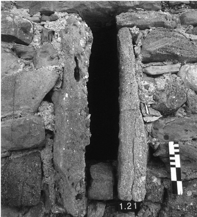
17: Schartenfenster mit zwei hochkant gestellten Sandsteinplatten als Gewände auf der Nordseite des 2. Obergeschosses; von N.
