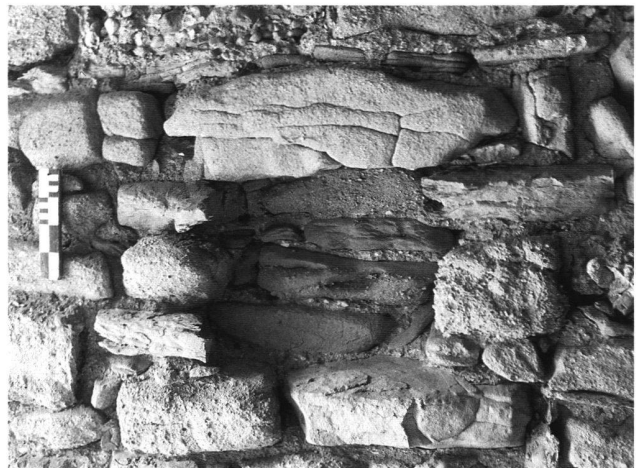
14: Lichtnische in der Westwand neben dem Hocheingang; von E.
