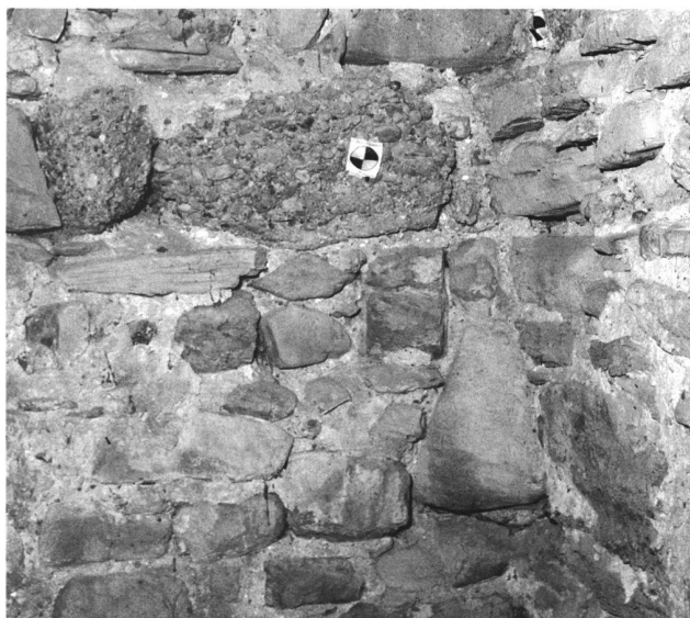
9: Nachträglich zugemauertes Gerüstbalkenloch auf der Innenseite der Nordwand des Sockelgeschosses; von SSW.
