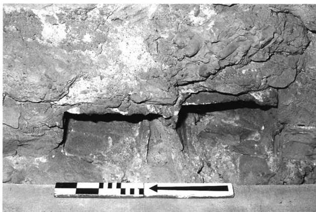
11: Zwei nebeneinander liegende Balkenlöcher in der Ostwand des 1. Obergeschosses; von W. Die hinter dem Nordpfeil sichtbare Mörtelbraue ist ein Hinweis darauf, dass das Balkenende nicht weit ins Turminnere gereicht hat.
