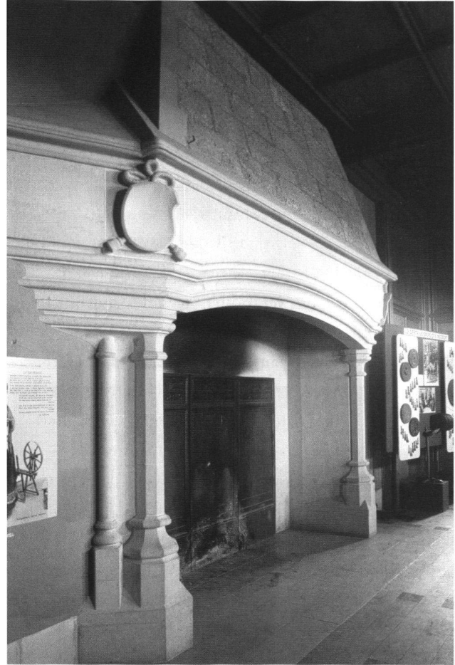
7: Cheminée d'Amédée VIII, reconstruite en matériaux modernes.
