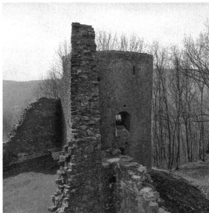
12: «Pulverturm» (L) mit westlichem Grat 2004, von Nordosten.
