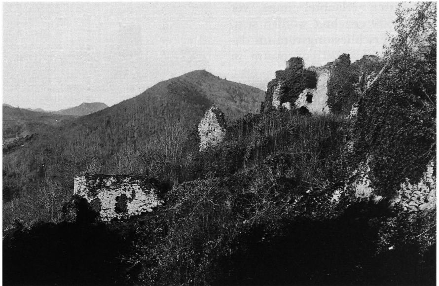
11: Unterburg (H) und Burggarten (J) 1931, von Osten.
