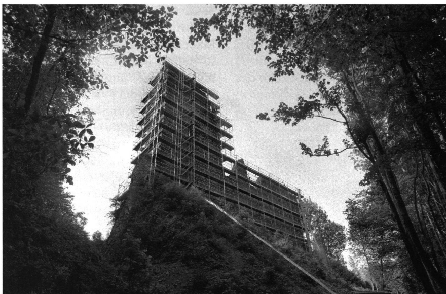
5: Der eingeriüstete Hauptturm und die Schildmauer während der Sanierung 2003, von Nordosten.
