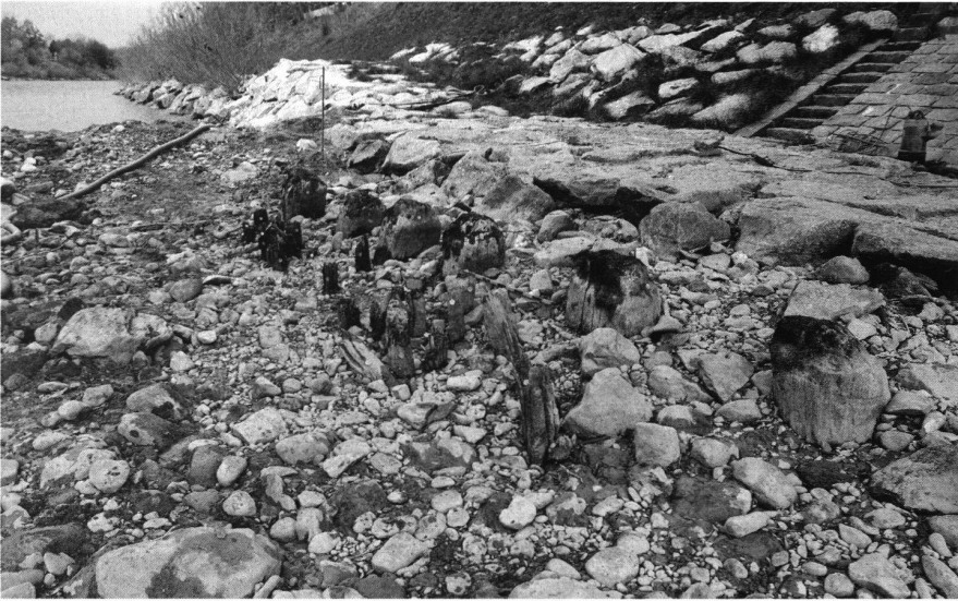
12: Eichenspältilinge, die 1545 zum Schutz vor Erosion im Uferbereich eingeschlagen wurden.
