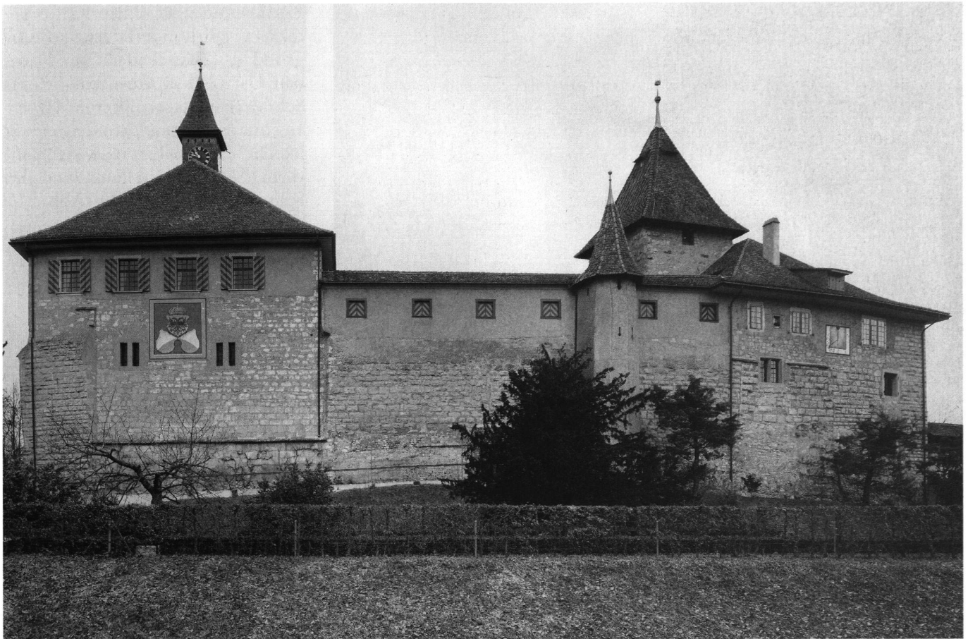
21: Ansicht der angriffsseitigen Front. Auffällig ist die Neigung des Kernbaus Süd nach rechts. Zwischen ihm und der Schildmauer befindet sich die 1472 erneuerte Fassade des «Ritterhauses». Vor der Schildmauer steht der polygonale, wohl noch im Spätmittelalter errichtete Schalenturm. Rechts erhebt sich der Kernbau Ost mit den erneuerten Teilen, dahinter ist noch der Bergfried zu sehen.
