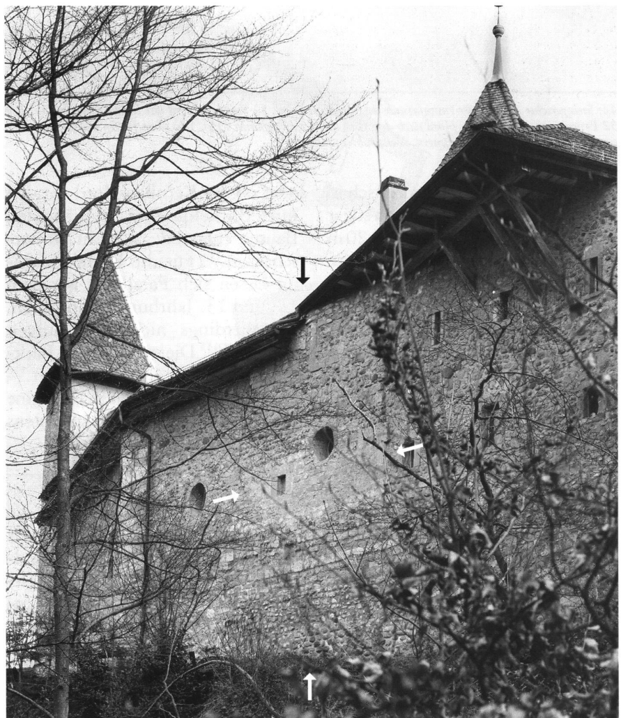
43: Ansicht der Nordringmauer. Im Zentrum befindet sich der Kernbau Nord, dessen Aussenwand teils aus Quaderwerk besteht (Pfeile). Von den beiden originalen Rechteckfenstern ist eines komplett erhalten, vom anderen ist noch das Gewände in der Abbruchkante der Mauer zu sehen (vgl. Abb. 46). Beidseits des Kernbaus stehen die erneuerten Mauern. Links ist die Ringmauer mit dem Willenturm zu sehen.
