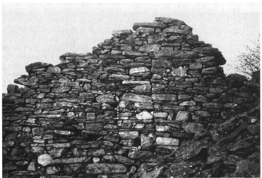
9: Caslasc, Orsino-Mauer. Oben nicht durchgehende Trennfuge zwischen M1 (links) und M2 (rechts). In der Ecke links unten das Detail von Abb. 14.
