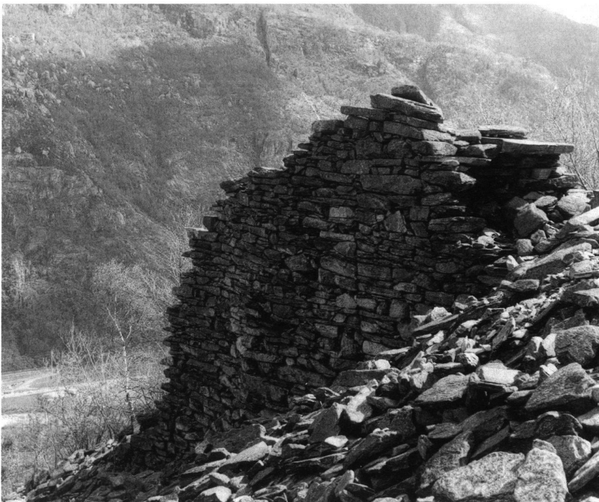
7: Caslasc. Orsino-Mauer (M1–M2), Ansicht von Westen. An dieser Stelle erreicht die Mauer M1 eindrucksvolle 7,5 m in der Höhe (senkrecht gemessen).
