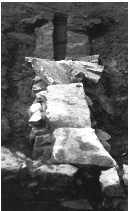
8: Kanal der Heizungsanlage. Sicht von Norden.
